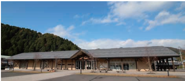
●鯖江市 越前漆器伝統産業会館「うるしの里会館」
